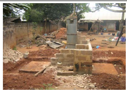
Un point d'eau construit à moins de 4 m d'une latrine à Sakété
