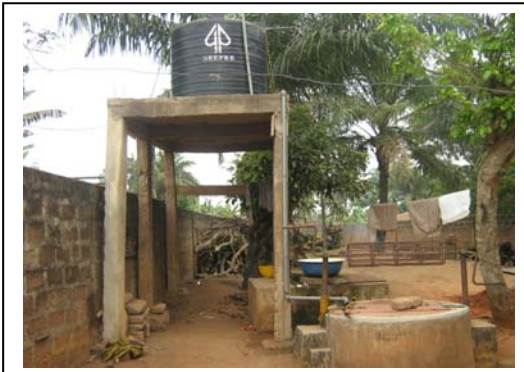
Un point d'eau construit à moins de 4 m d'une latrine à Sakété
